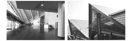
<그림13> 송도컨벤시아의 내·외부 전경12)
